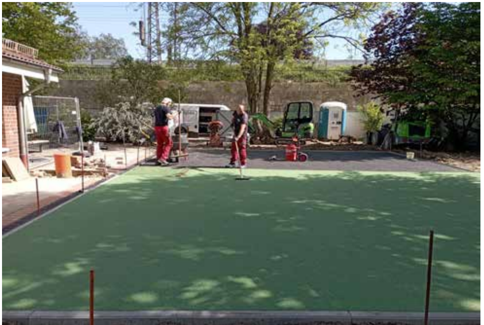
Fast fertig: Der größte Teil des Kunststoffrasens ist bereits ausgerollt.
