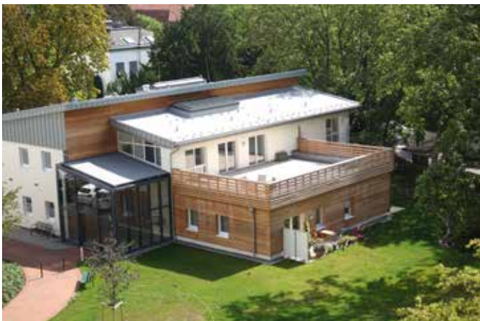
Acht Wohnungen für „altersgerechtes Wohnen“ am Heywinkel-Haus
