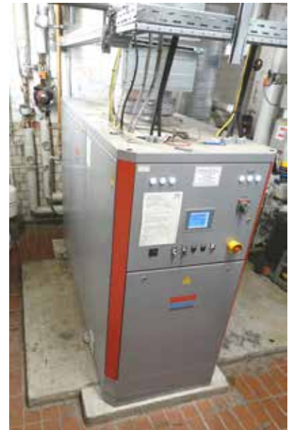
Das moderne Blockheizkraftwerk erzeugt Strom und Wärme gleichzeitig.
