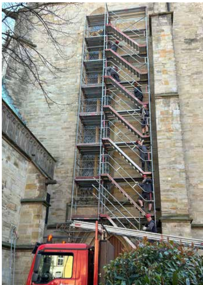
Gut gerüstet - Mitarbeiter der Firma Wedekind-Kern aus Melle erstellen bereits Anfang April auf der Nordseite der Marienkirche ein Gerüst, damit gleich nach der Konfirmation am 27. April die dritte Bauphase der Renovierung der Kirchenfenster beginnen konnte.
