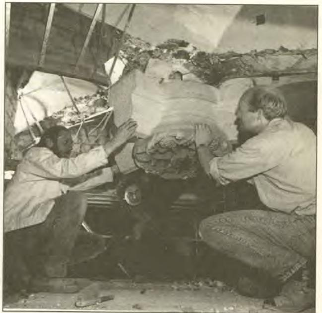
Anbringen des neuen Schlusssteins über der Orgel: Gewicht ca. 800 Kilo. Für das Hochziehen musste der Dachstuhl verstärkt werden (rechts: Steinmetzmeister Werner Paetzke).
