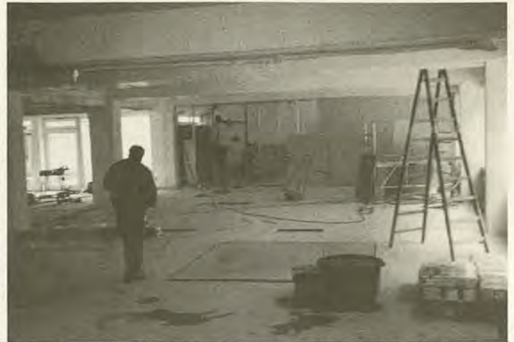
Kaum wiederzuerkennen: Der Eingangsbereich des Senioren-Hauses in der Bergstraße. Wo die Besucher früher vor die Garderobenwand liefen, öffnet sich nun ein großzügiges Foyer, das zu größeren Veranstaltungen auch mit dem Speisesaal verbunden werden kann. Ebenfalls eine Umgestaltung hat der Andachtsraum erhalten, in dem die Bewohnerinnen und Bewohner wöchentlich Gottesdienst feiern.
