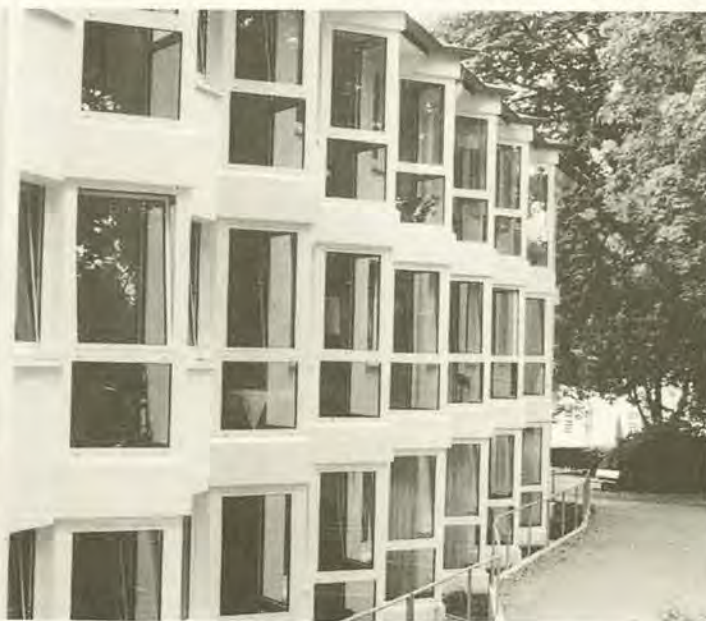
Den Blick ins Grüne gestatten die balkonförmig verglasten Fensterinseln im neuen Wohnbereich des Heywinkel-Hauses. Foto: Dieter Rathig
