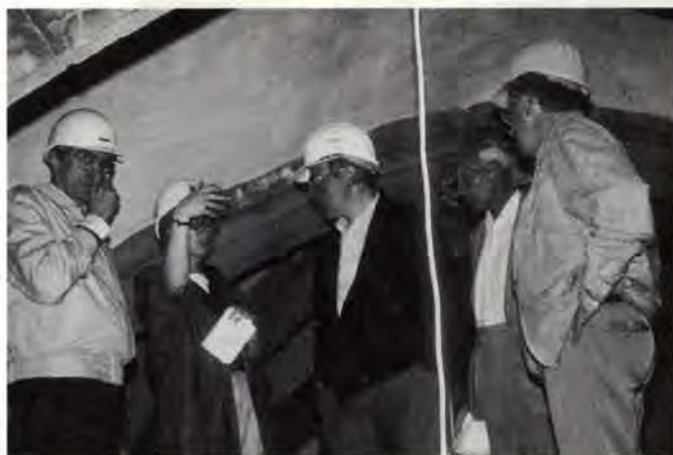
Ortstermin an der Baustelle
