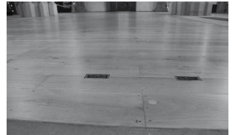
Foto 2: Fertiger Boden mit Lüftungsöffnungen
