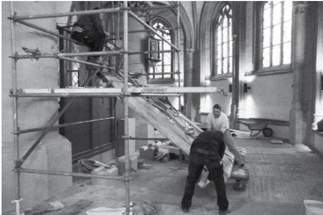
Foto 6: „Möser“ wird per Flaschenzug behutsam flachgelegt
