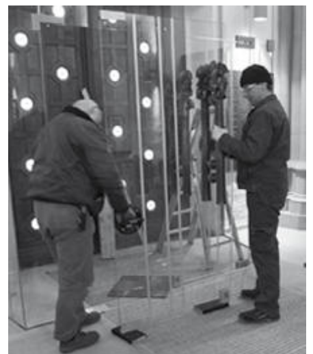
Foto 4: Schmutzfangmatten – rechts mit Bürsten Foto 5: Montage der Türflügel
