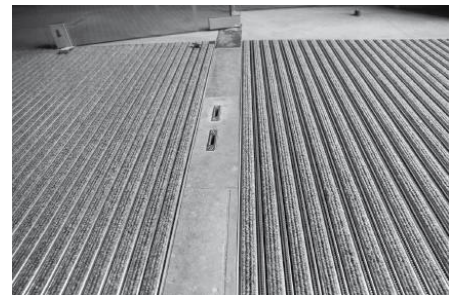
Foto 4: Schmutzfangmatten – rechts mit Bürsten Foto 5: Montage der Türflügel
