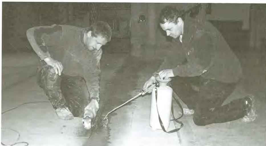
Kai Wüpping (links) und Jürgen Veerkamp (Steinmetzbetrieb Werner Paetzke) schneiden am 12.11.2008 neue Kabelschlitze unter Wassereinsatz in den Chorraum, um Staubentwicklung zu vermeiden. Die versteckten Kabel versorgen die neuen Lautsprecher im Chor, die den dort Tätigen das Mithören ihrer Wortbeiträge ermöglichen. Sonst bleibt man da vorne akustisch isoliert.
